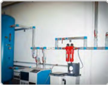
Réseaux de distribution en aluminium pour air comprimé, vide, argon, azote, dioxyde de carbone, huiles minérales et synthétiques, gaz non dangereux et autres fluides de 20 à 110 mm de diamètre intérieur.
