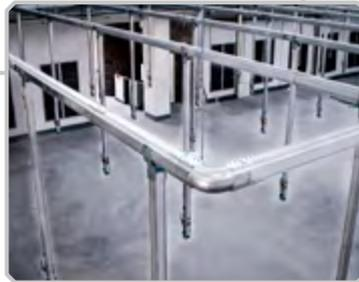
Réseaux de distribution en aluminium pour air comprimé et autres fluides de 20 à 110 mm de diamètre intérieur. Les gammes HBS, APS, MPS et DCS sont parfaites pour ces applications.
