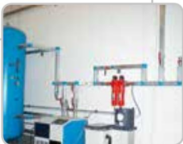
Алюминиевые сети распределения сжатого воздуха, вакуума и других безопасных газов с внутренним диаметром от 20 до 110 мм.
