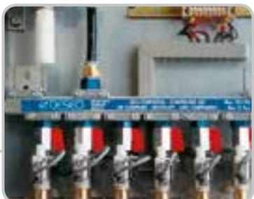
Интегрированные распределительные коллекторы с пневматическими панелями управления для автоматизации.
