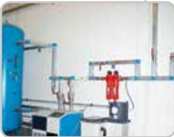
Réseaux de distribution en aluminium pour air comprimé, mise sous vide et autres gaz inoffensifs, diamètre de 20 à 110 mm.
