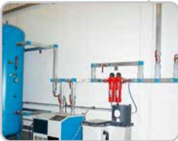
Verteilungsnetze in Aluminium für Druckluft, Vakuum und andere ungefährliche Gase, von 20 bis 110 mm Durchmesser.
