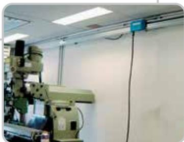
Unter Druck stehende Schwenkarme aus Aluminium für die Druckluftversorgung von Werkzeugen. Großer Anwendungsradius.
